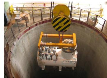
Figure 3.5 : descente d'une unité de réfrigération 1,8 K dans le tunnel du CERN
